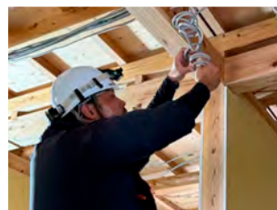
電気配線作業(新築放課後等 デイサービス施設)
