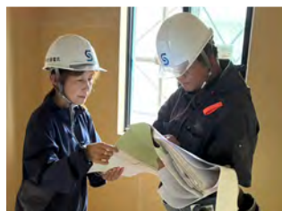
現場打合せ風景(新築マンション施工)
