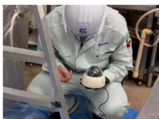
防犯カメラ設置作業
