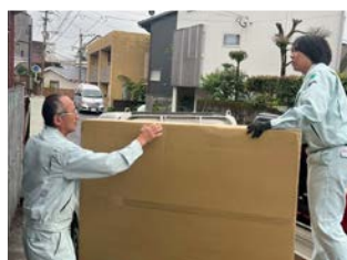
マンション分電盤荷受作業
