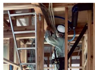
戸建て配線作業
