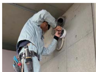
防犯カメラ撤去工事
