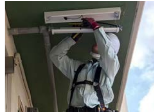
不動産管理サポートによる 非常灯交換工事
