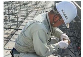
新築戸建電気工事基礎配管工事
