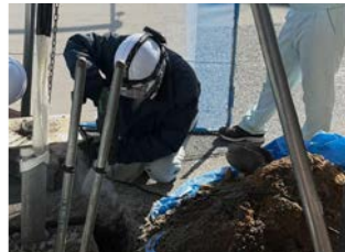
看板灯電気工事
