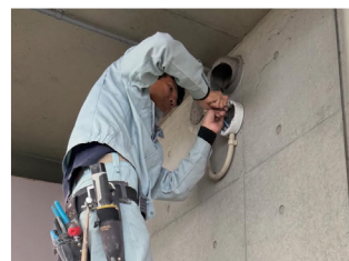
防犯カメラ撤去工事
