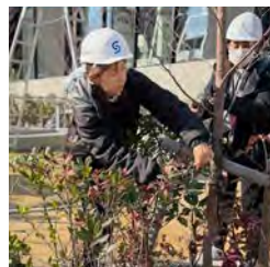
イルミネーション配線取付工事
