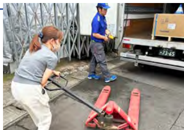
天井用カセット型エアコン荷下ろし
