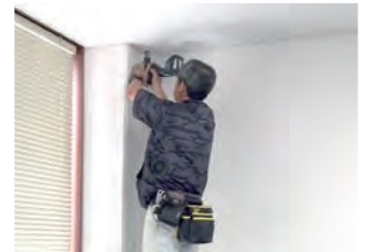
オフィス工事(配線工事)
