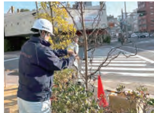
イルミネーション取付工事
